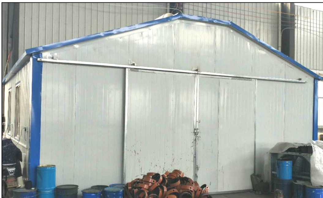
图 3-1 刷粘合剂封闭间
